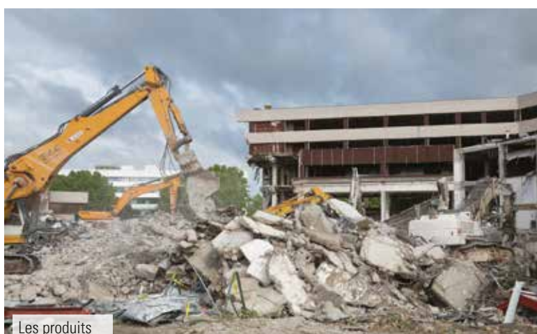
Les produits destinés au réemploi ne prennent pas le statut de déchet...
